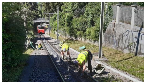
Schotterbett jäten bei der Dolderbahn, Zürich
